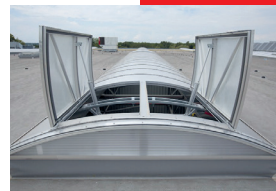
KLAPY ODDYMIAJĄCE W PASMACH ŚWIETLNYCH
